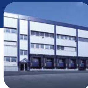
Inbetriebnahme des neuen Zentrallagers 2013
