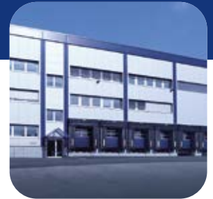
Inbedrijfname van het nieuwe centrale magazijn in 2013
