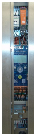
Abbildung 34: Die Steuerungen werden in Schaltschränken zur Wandmontage, als Standschranke oder in Türzargen eingebaut geliefert.
