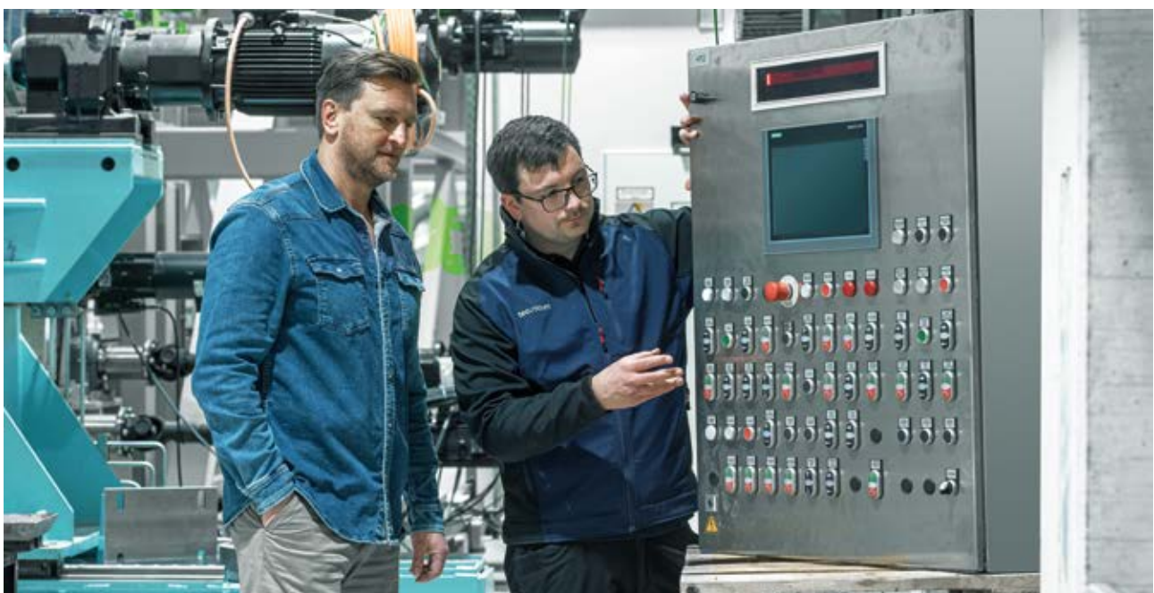
Die IIoT-Lösung „Energy Management Solution“ schafft die Voraussetzung für die Optimierung des Energieverbrauchs in der Produktion.
